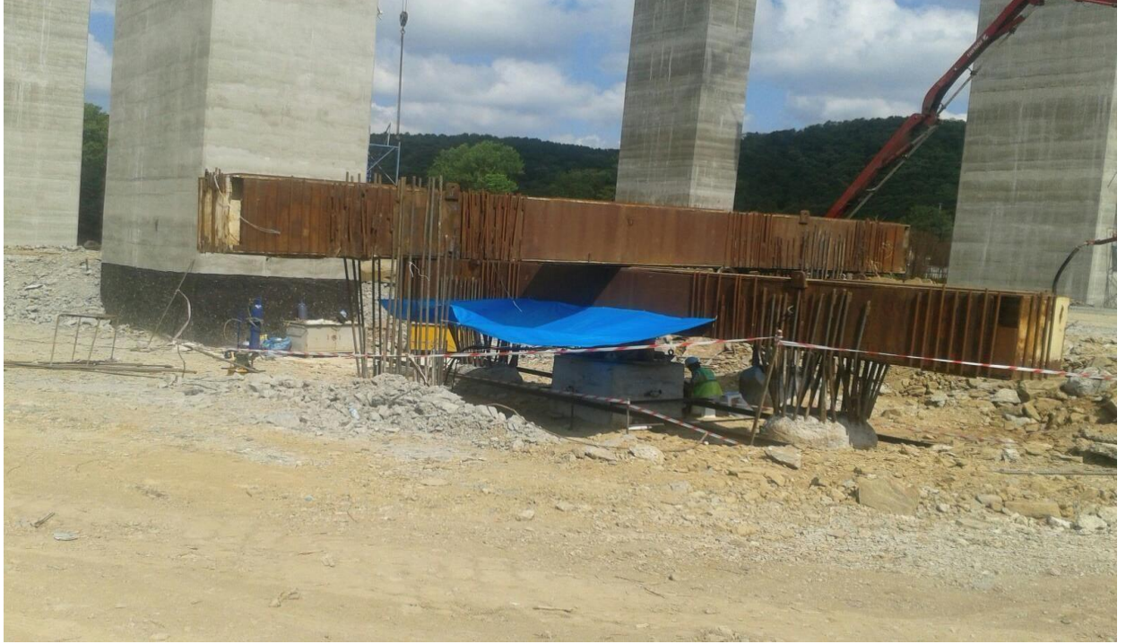
Kuzey Marmara (3. Boğaz Köprüsü Dahil) Otoyolu Projesi V26 Viyadüğü G6 Temeli Eksenel Kazık Yükleme Deneyi
